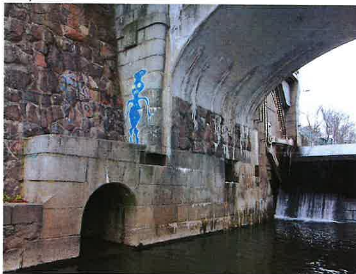
29) Krajní OP1 (pravobřežní) – otvor č. 1 / vyústění rybího přechodu
