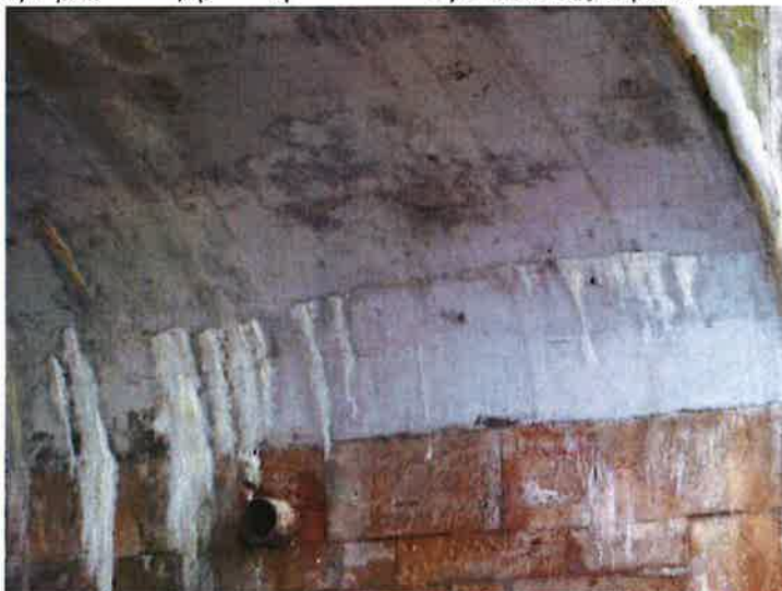
27) NK – pole č. 3 (výtok) v podhledu / průsaky nefunkční hydroizolace, vápenocementové výluhy
