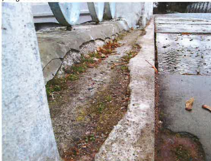
14) Nefunkční nátěr PKO model zábradlí
