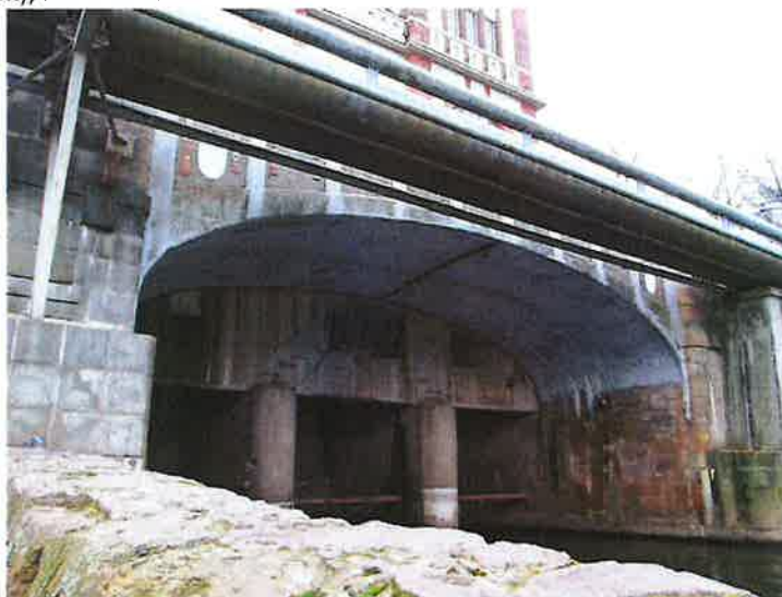
26) NK – pole č. 3 (výtok) v podhledu / průsaky nefunkční hydroizolace, vápenocementové výluhy
