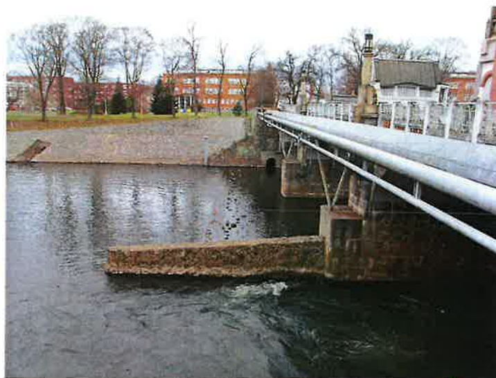
53) Cizí zařízení vpravo (výtok) / horkovodní vedení na ocelových konzolách s podpěrou na mezilehlých pilířích – ve správě ČEZ
