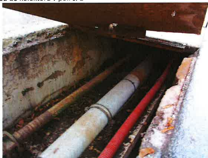
57) Cizí zařízení – pohled do kolektoru v poli č. 1
