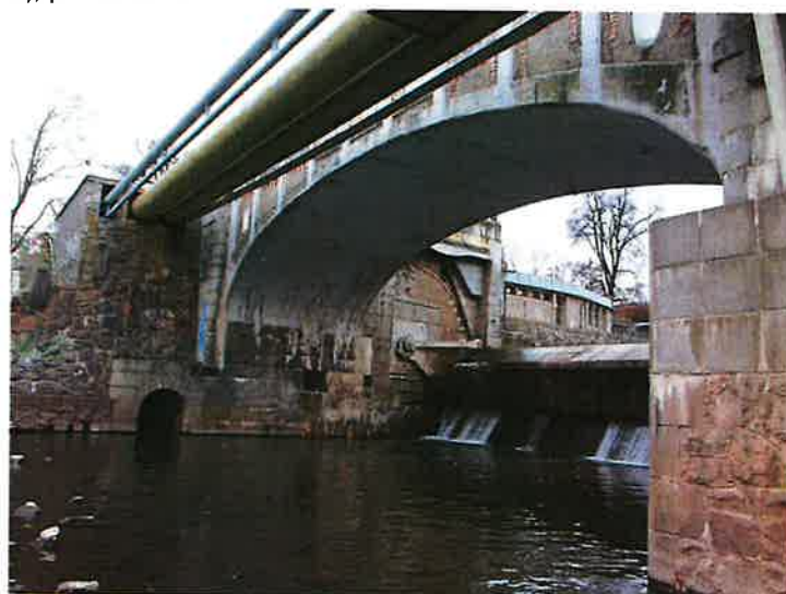
18) NK – pole č. 1 (výtok) v podhledu průsaky a zatékání
