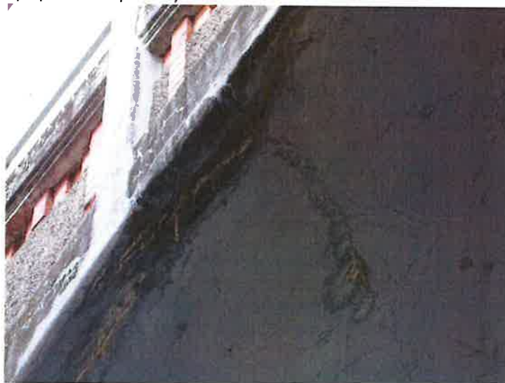
18) NK – pole č. 1 (výtok) v podhledu průsaky a zatékání
