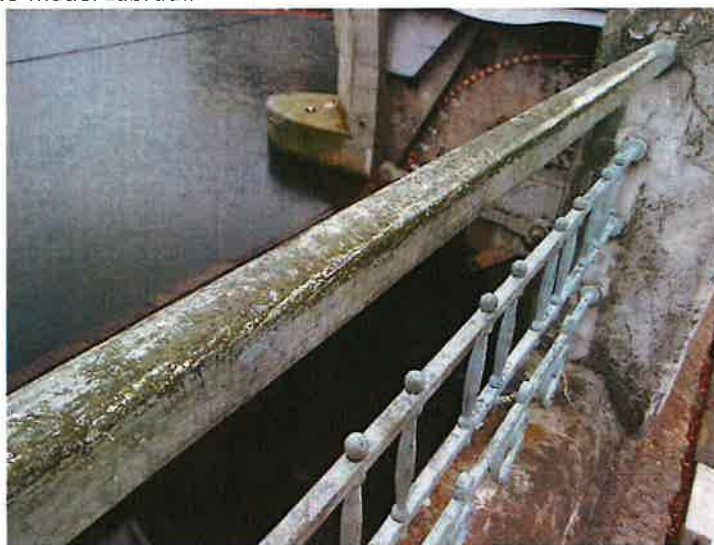
14) Nefunkční nátěr PKO model zábradlí
