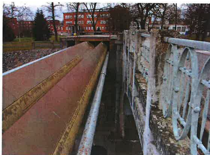
54) Cizí zařízení vpravo (výtok) / horkovodní vedení na ocelových konzolách s podpěrou na mezilehlých pilířích – ve správě ČEZ
