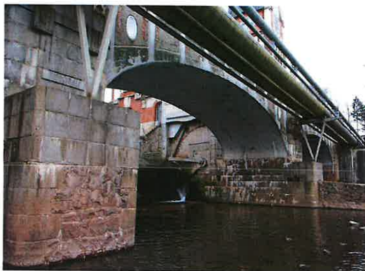
54) Cizí zařízení vpravo (výtok) / horkovodní vedení na ocelových konzolách s podpěrou na mezilehlých pilířích – ve správě ČEZ
