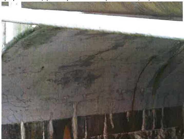
26) NK – pole č. 3 (výtok) v podhledu / průsaky nefunkční hydroizolace, vápenocementové výluhy
